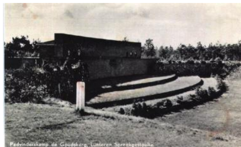
Fig. 2: Foto van de muur van na de oorlog, opschrift luidt: ‘Padvindskamp de Goudsberg, Lunteren Spreekgestoelte’. (Bron: Vereniging Oud-Lunteren).
